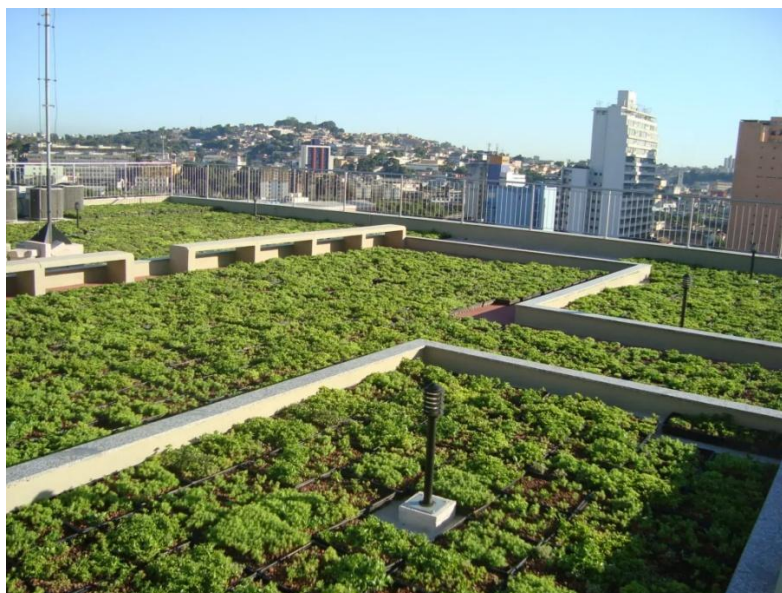
Figura 12 – Telhado verde instalado sobre edifício.
