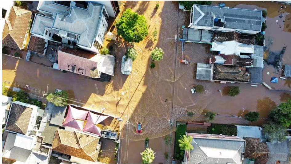
Figura 6 – Ruas completamente alagadas devido a inundaç o em Porto Alegre/RS.
