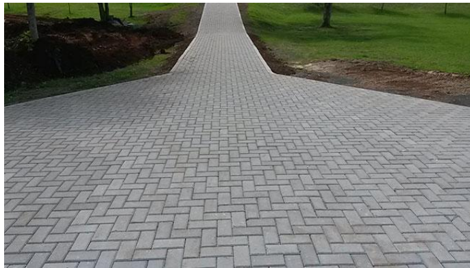
Figura 13 – Pavimento permeável executado com blocos intertravados.
