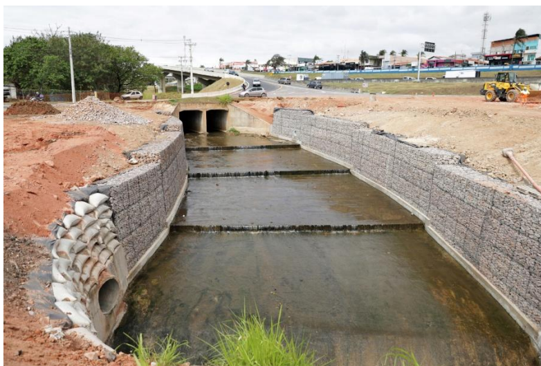
Figura 10 – Canalização do córrego Sapenzal – Louveira (SP).
