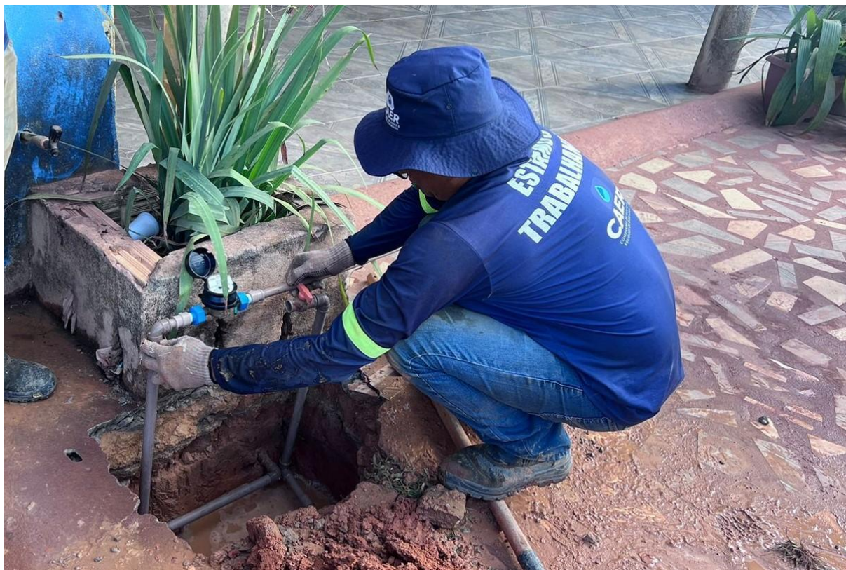
Figura 3 - Instalação de medidor em uma residência
