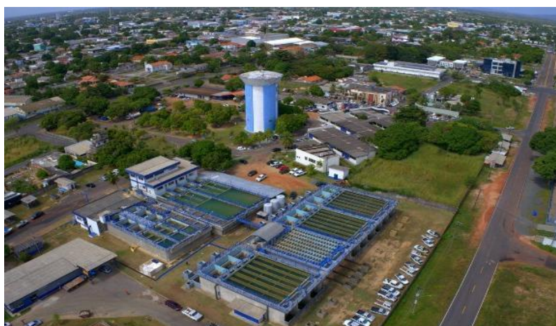
Figura 7 - Estação de Tratamento de Água da CAER
