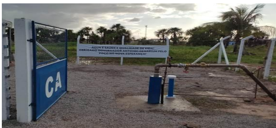
Figura 5 - Poço tubular no bairro Equatorial
