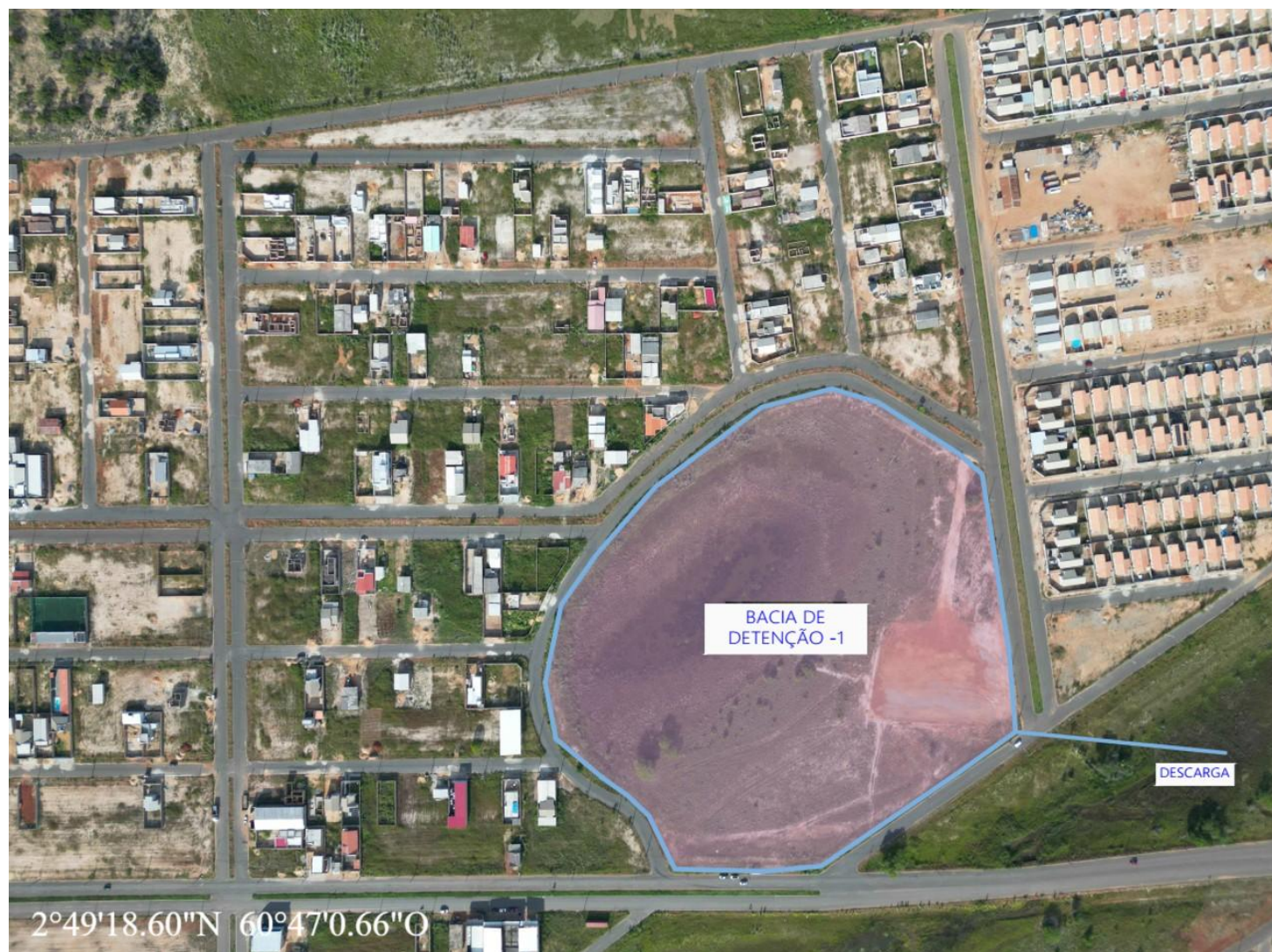
Figura 34 - Vista aérea do local de implantação da bacia de retenção 1.
