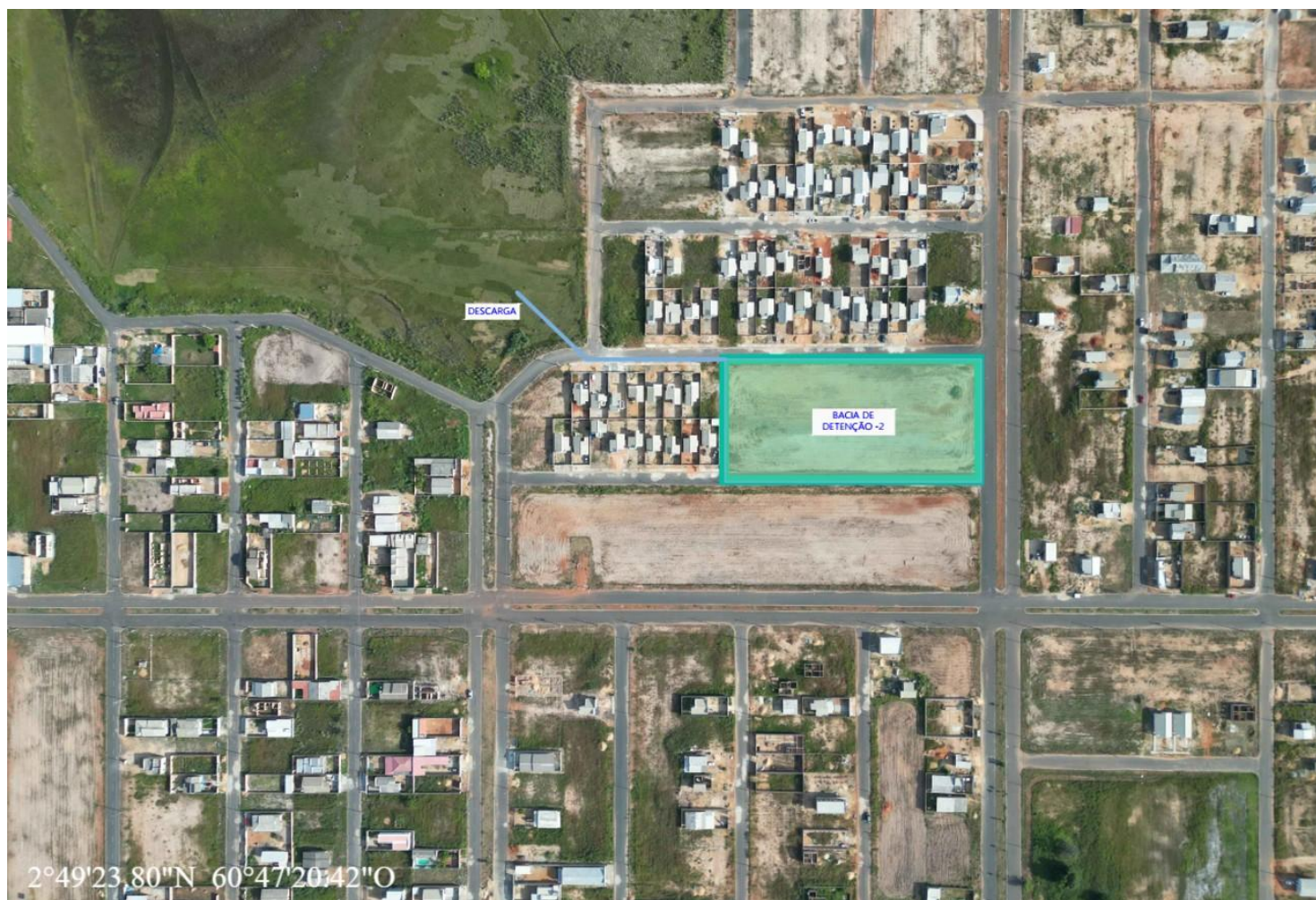
Figura 3535 - Vista aérea do local de implantação da bacia de retenção 2.
