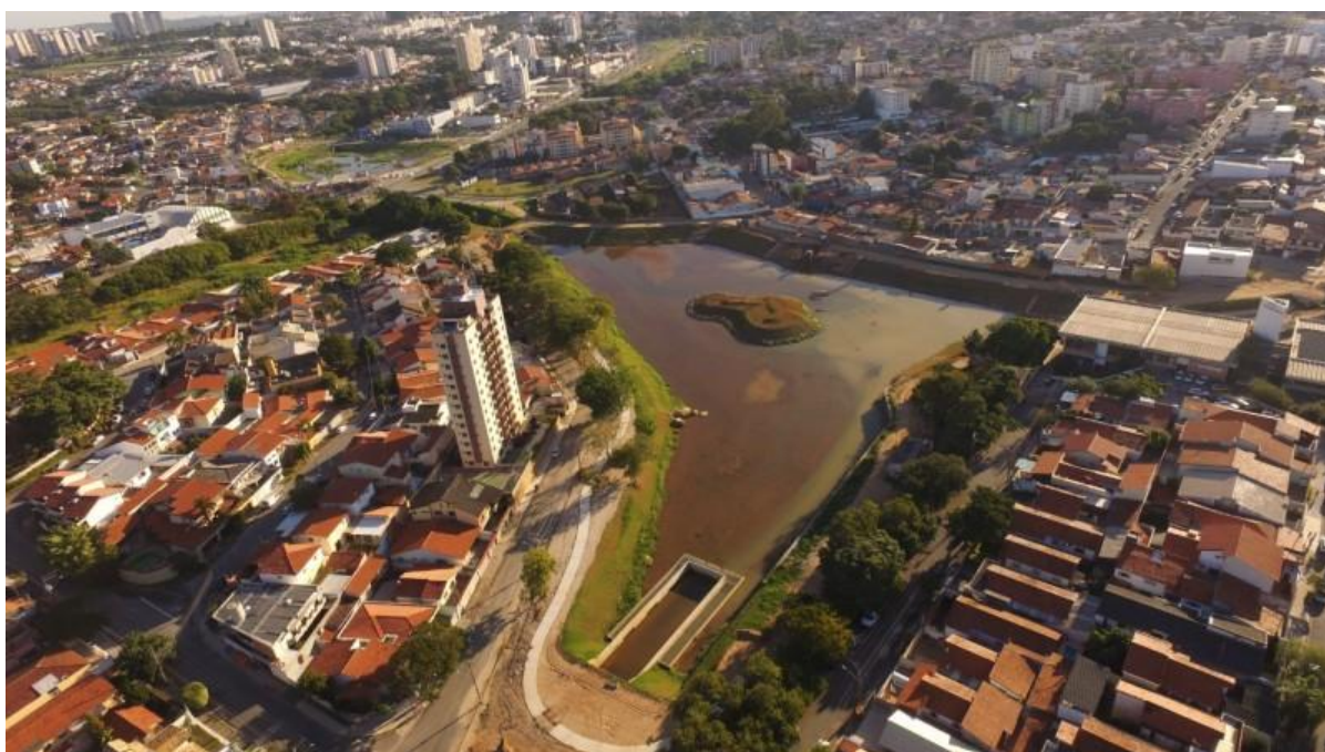
Figura 22 - Reservatório de Detenção de Cheias (RDC) do Córrego Água Vermelha.
