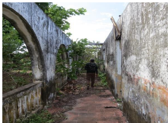
Figura 5 – Sede da fazenda em ruínas
