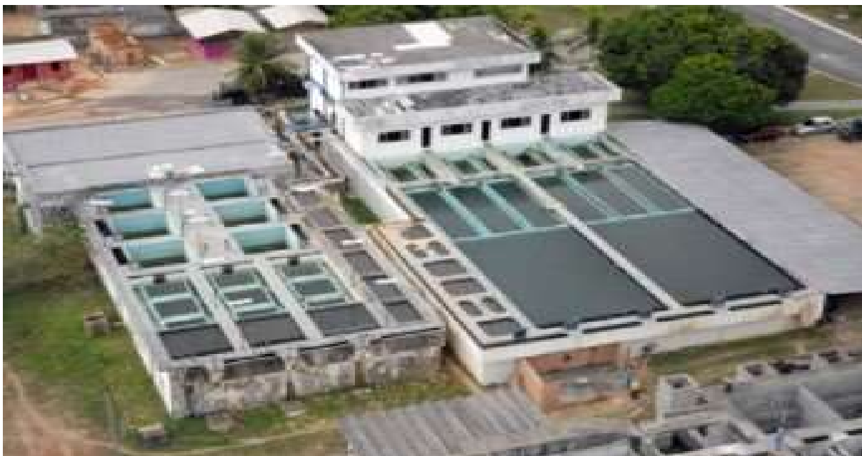
Figura 4 - Foto Estação de Tratamento de Água - ETA / CAER
