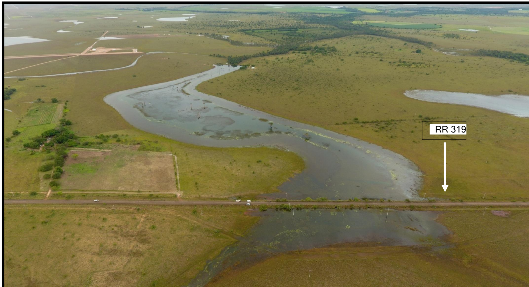
Figura 24- Nascente 1 com visada para Leste. Ela é cortada pela rodovia de acesso à vila Passarão (RR 319) e abaixo à direita, fora da foto, há um matadouro de cabras (2°59'9.94"N / 60°44'13.29"O). Ao fundo, vê-se um barramento.
