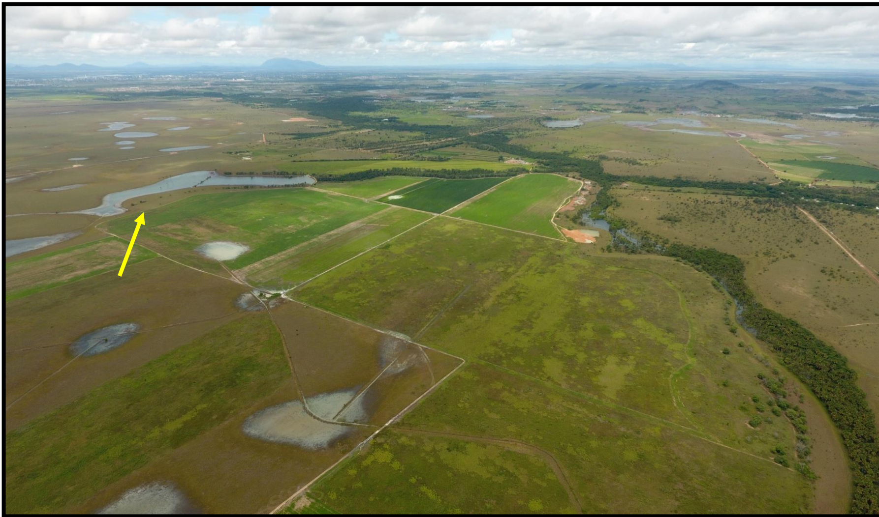
Figura 27 - Nascente 2 em visada para SSO. A leste dessa nascente (à esquerda, fora da foto) encontra-se a UTE Jaguatirica.
