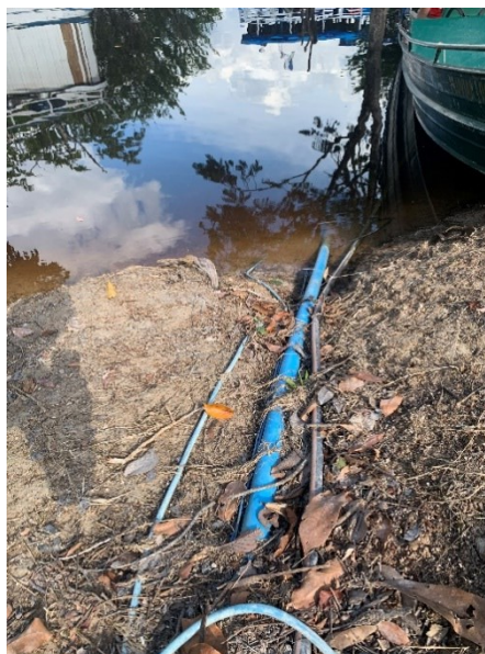
Figura 21 – Tubulação de água sem utilização em Xixuaú
