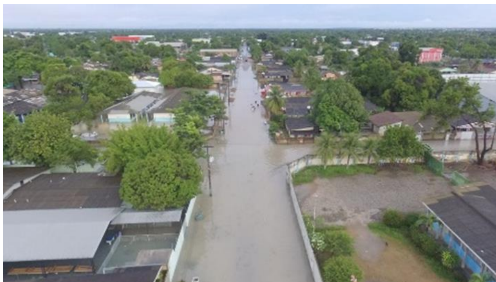
Figura 3 - Rua alagada com sistema de microdrenagem implantado
