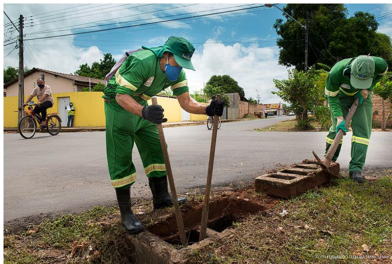
Figura 4 - Patrulha da chuva realizando a limpeza de boca de lobo
