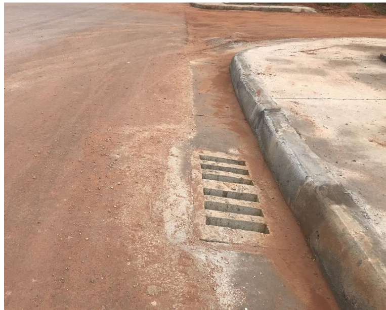
Figura 23 - Boca de Lobo com grelha executada no Bairro João de Barro
