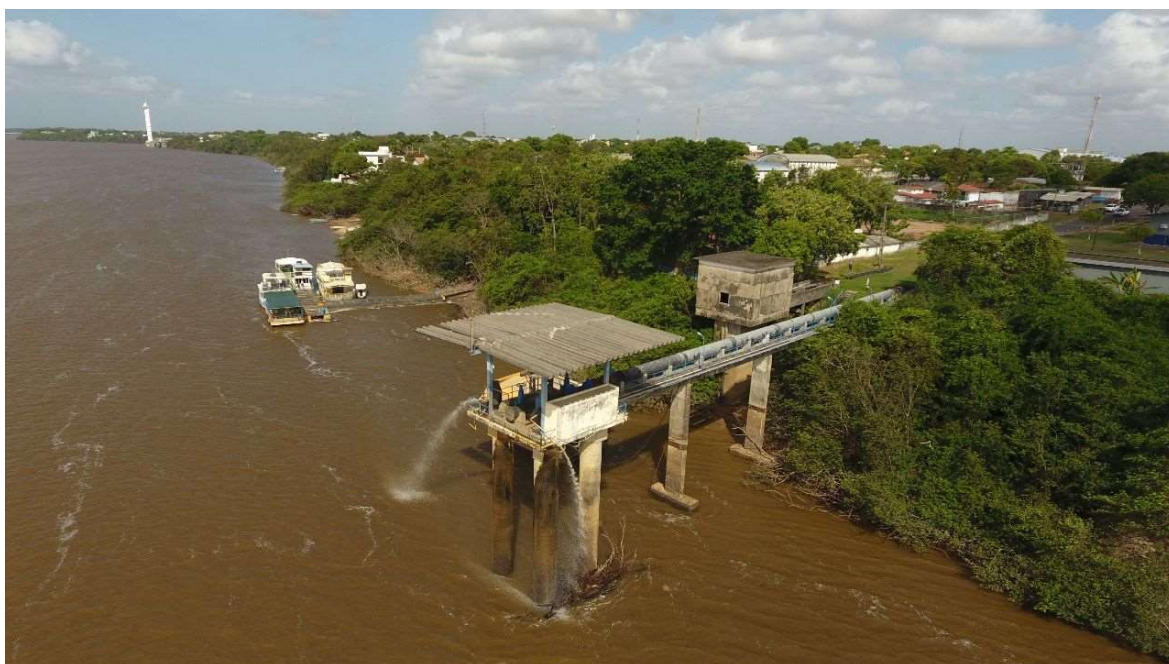
Figura 20 – Captação do bairro São Pedro.
