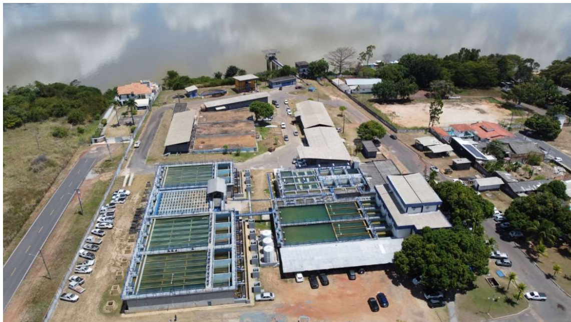
Figura 3 – Estação de tratamento de água do município de Boa vista - RR
