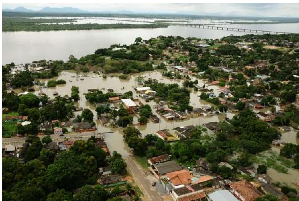
Figura 4 – Registro da última enchente ocorrida em Boa Vista-RR, no ano de 2011
