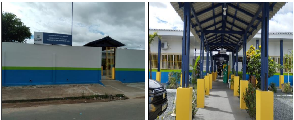
Figura 4 - Fachada da escola depois da reforma
