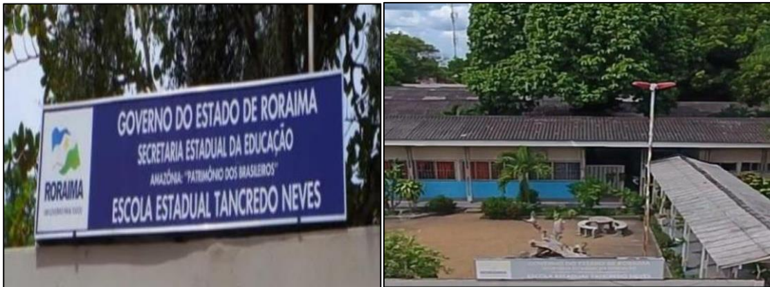
Figura 3 - Fachada da escola antes da reforma
