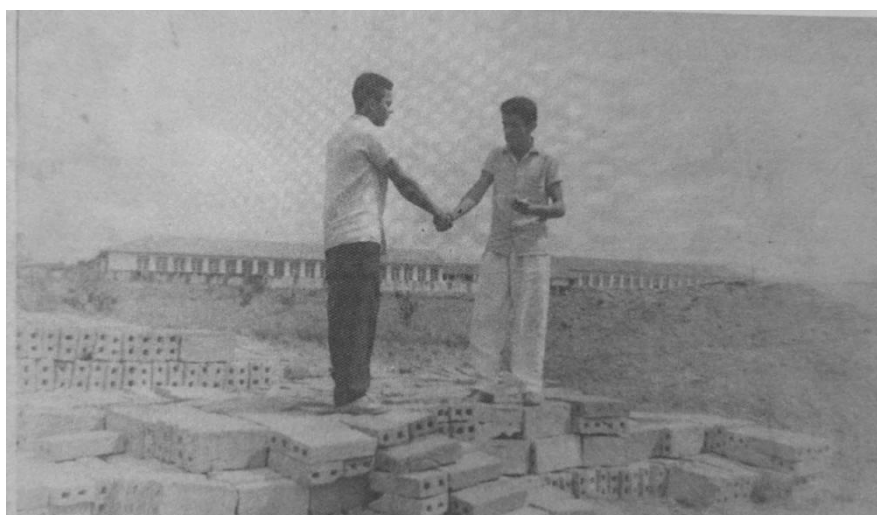
Figura 19 – Lideranças da URES na campanha pela construção da sede própria da entidade 1
