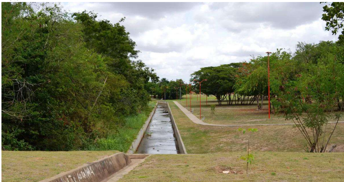
Figura 18 – Praça do Mirandinha e parte do trecho canalizado do igarapé em Boa Vista-RR.
