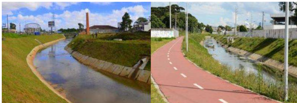
Figura 13 – Rio Ressaca após a revitalização.
