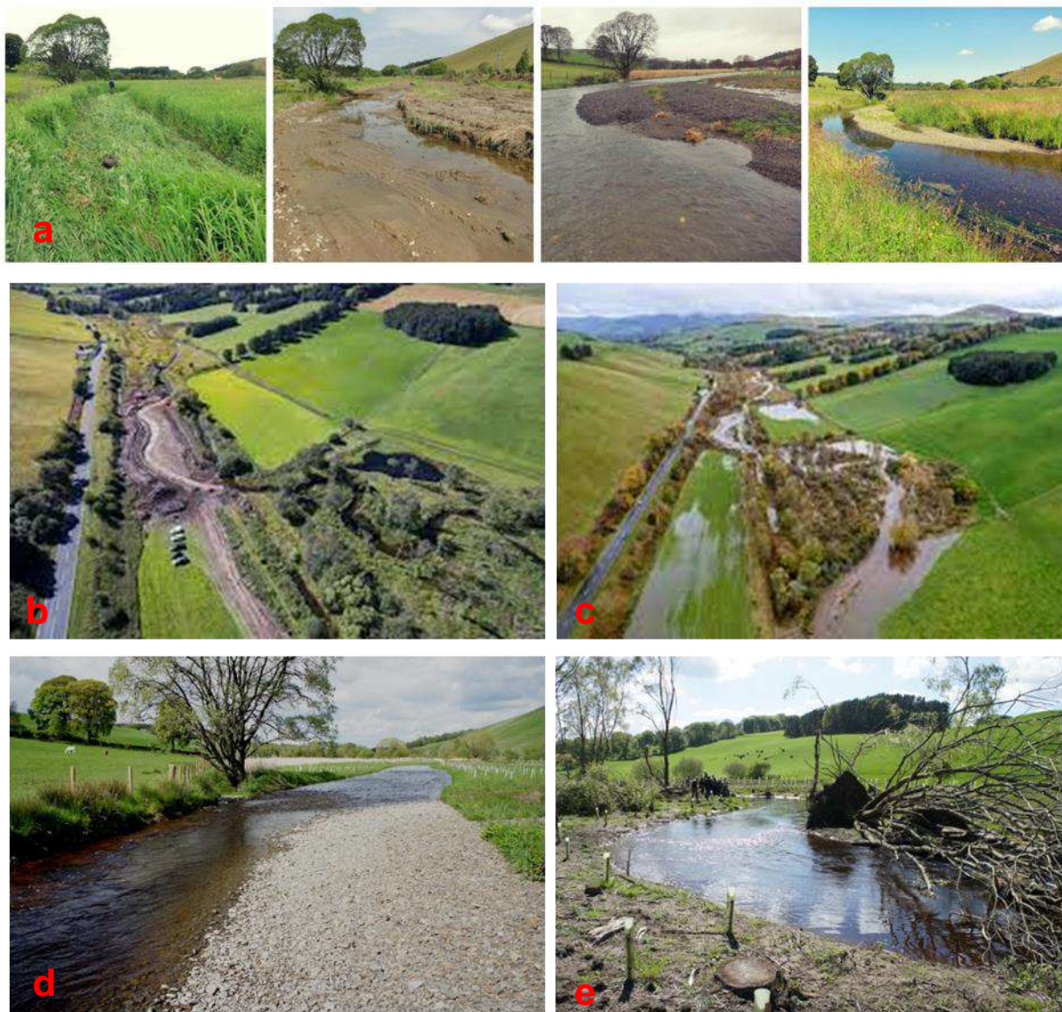
Figura 10 – Antes e depois do projeto de revitalização (a); execução do projeto de revitalização (b); período de cheia do rio após a revitalização (c); reestabelecimento de meandros (d); criação de habitats e meandros e pontos de monitoramento (e).
