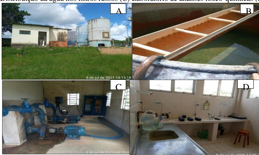
Figura 13 – Controle de bombas (A), Tanque de decantação na ETA - Estação de Tratamento da Água (B), Distribuição da água nos filtros russos (C) Laboratório de análises físico-químicas (D)
