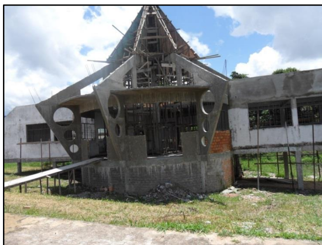
Figura 51– Vista Parcial das obras da Nave do Saber.
