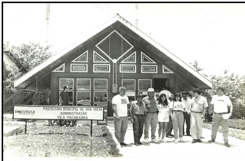
Figura 31 - Vista da fachada da sede da administração da vila de Pacaraima em 1993
