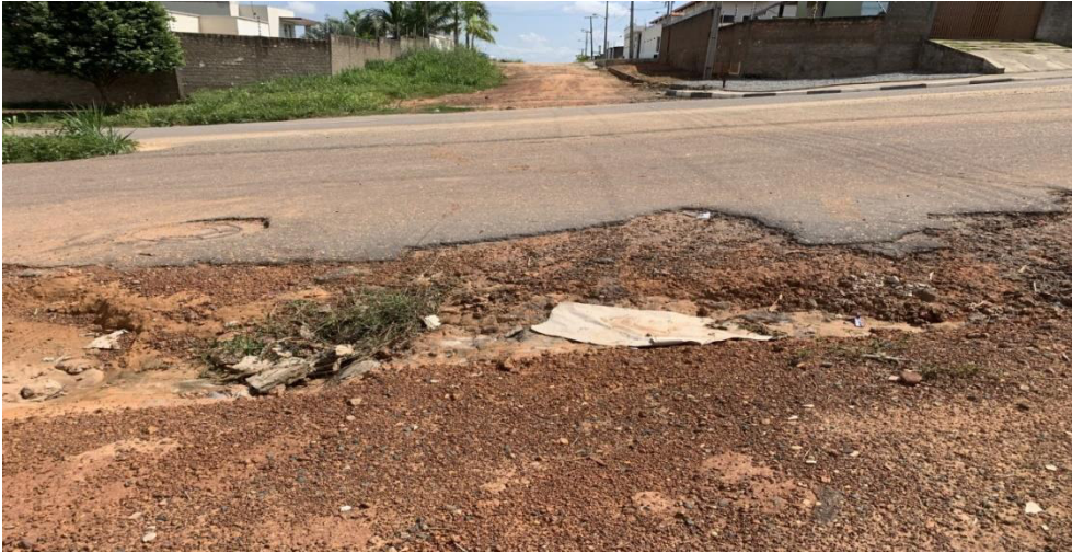
Figura 49 – Erosão linear em área urbana (Boa vista, RR)
