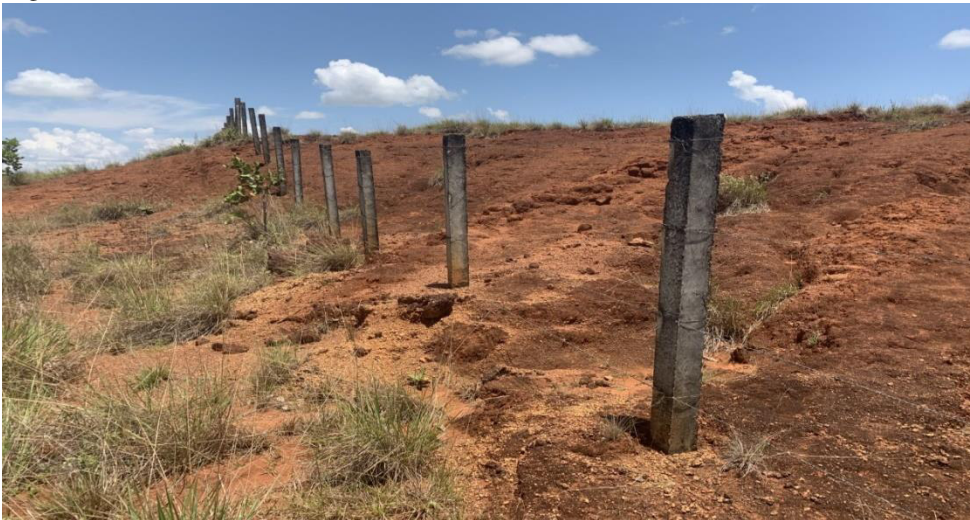
Figura 50 – Erosão linear na bacia do Cauamé
