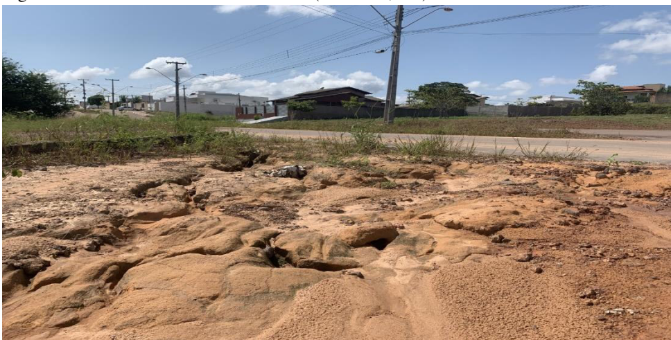
Figura 48 – Erosão linear em área urbana (Boa vista, RR)
