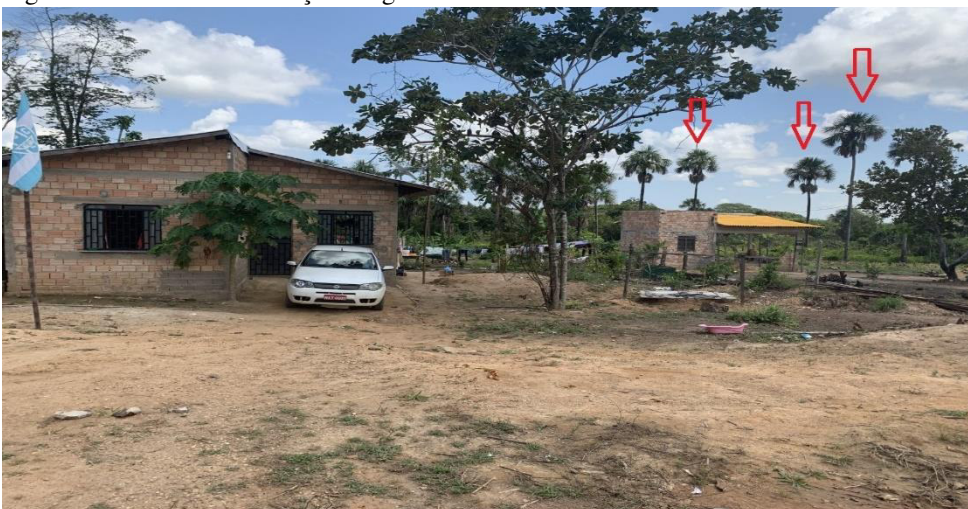
Figura 45 – Área de construção irregular localizada em APP
