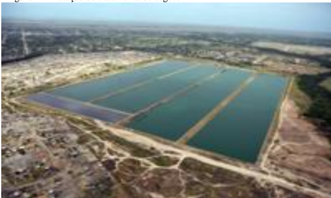
Figura 12 - Estação de tratamento de esgoto
