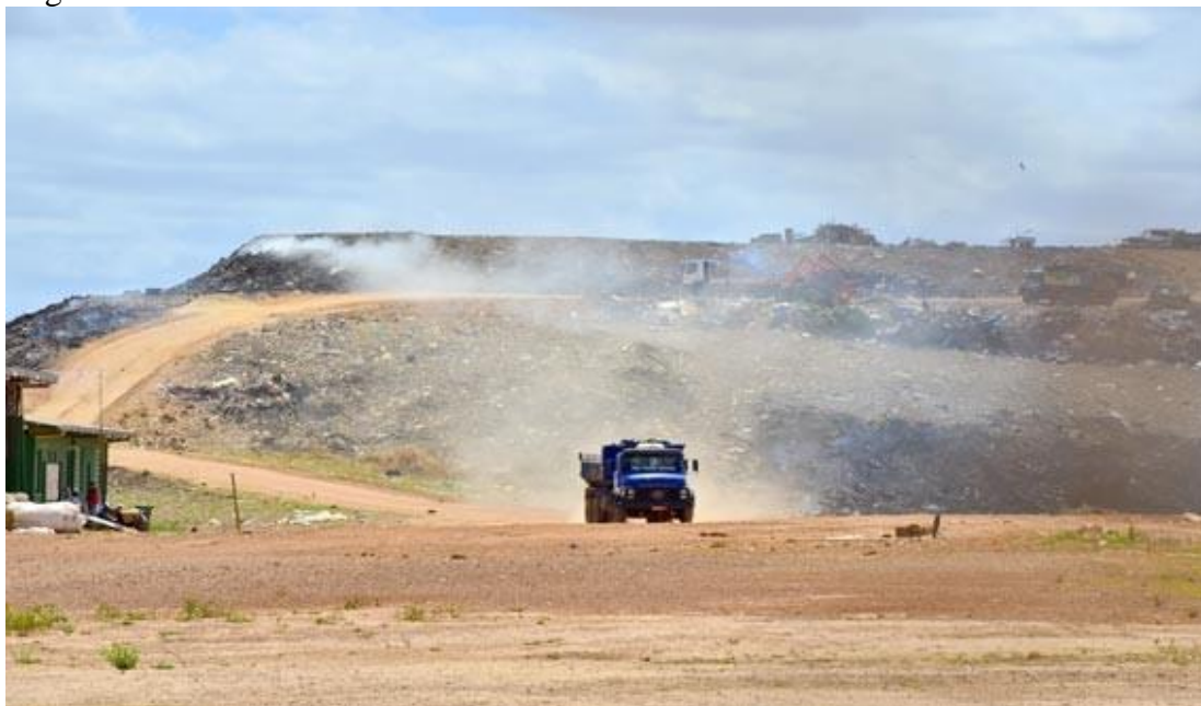
Figura 16 – Vista do aterro sanitário de Boa Vista
