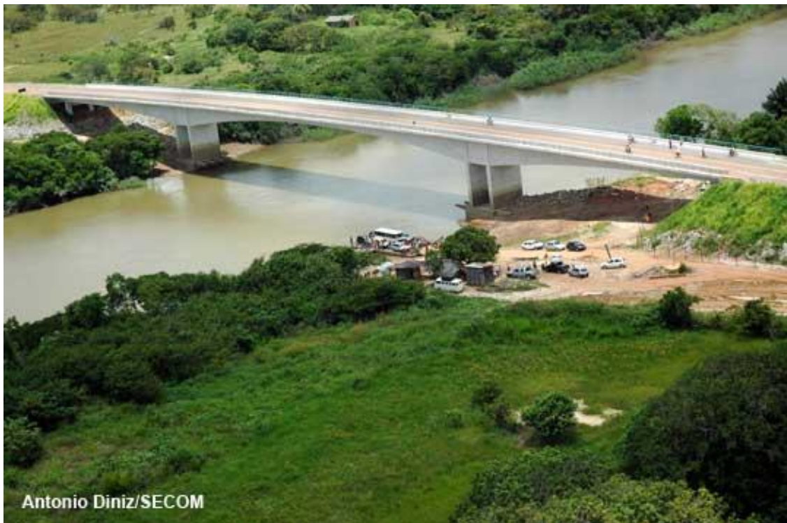
Foto 1 – Vista aérea da ponte sobre o rio Tacutu
