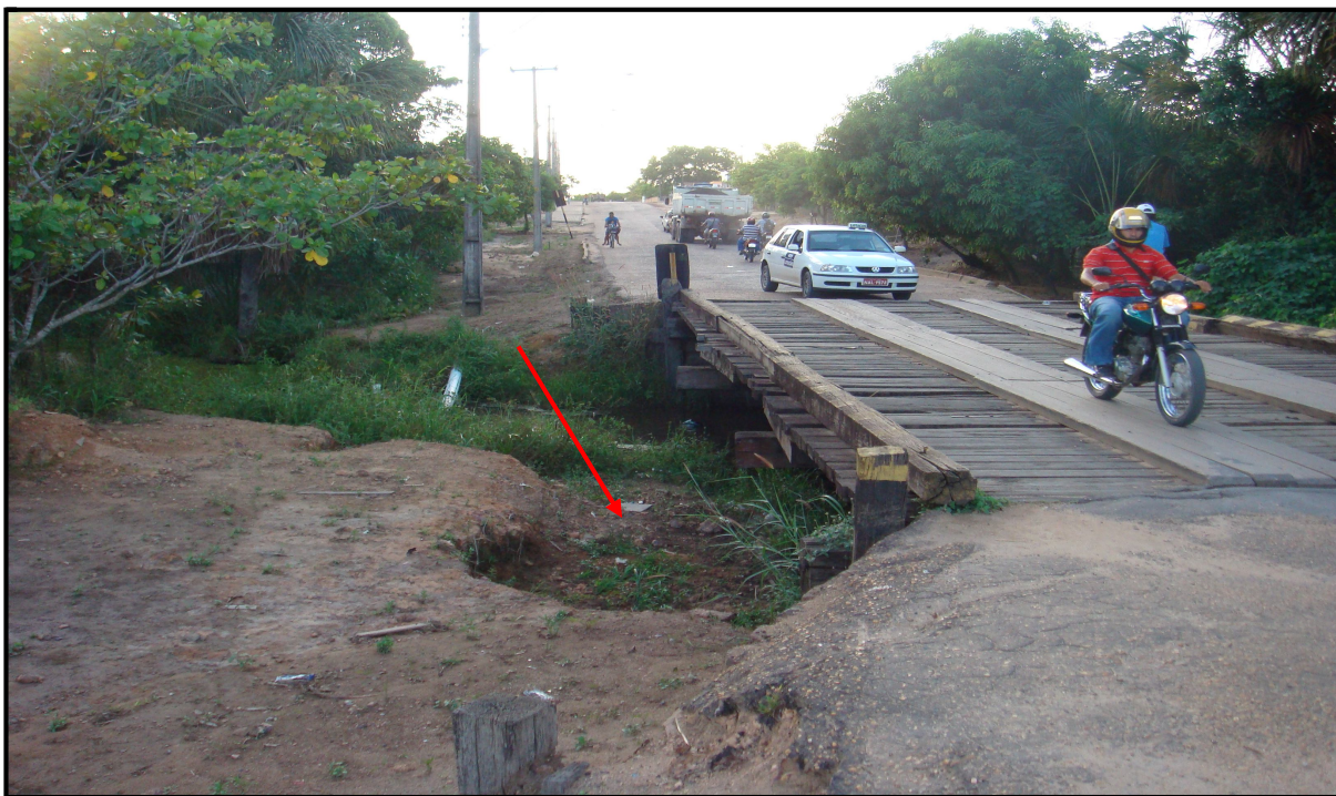
Figura 41 - Processo de erosão na transversal do igarapé Grande localizado em Boa Vista.
