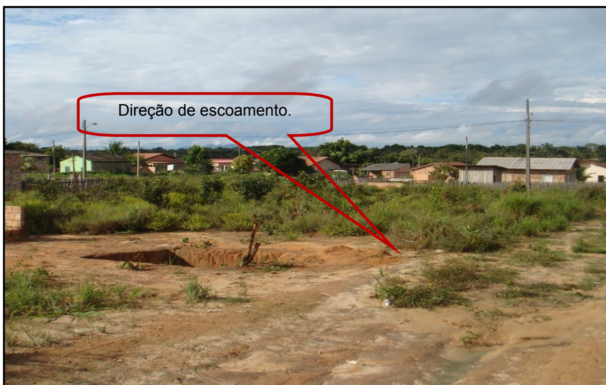
Figura 43 - Residências sobrepondo o canal de drenagem natural afluente do igarapé Grande extinto pela ocupação. Bairro Centenário em Boa Vista.
