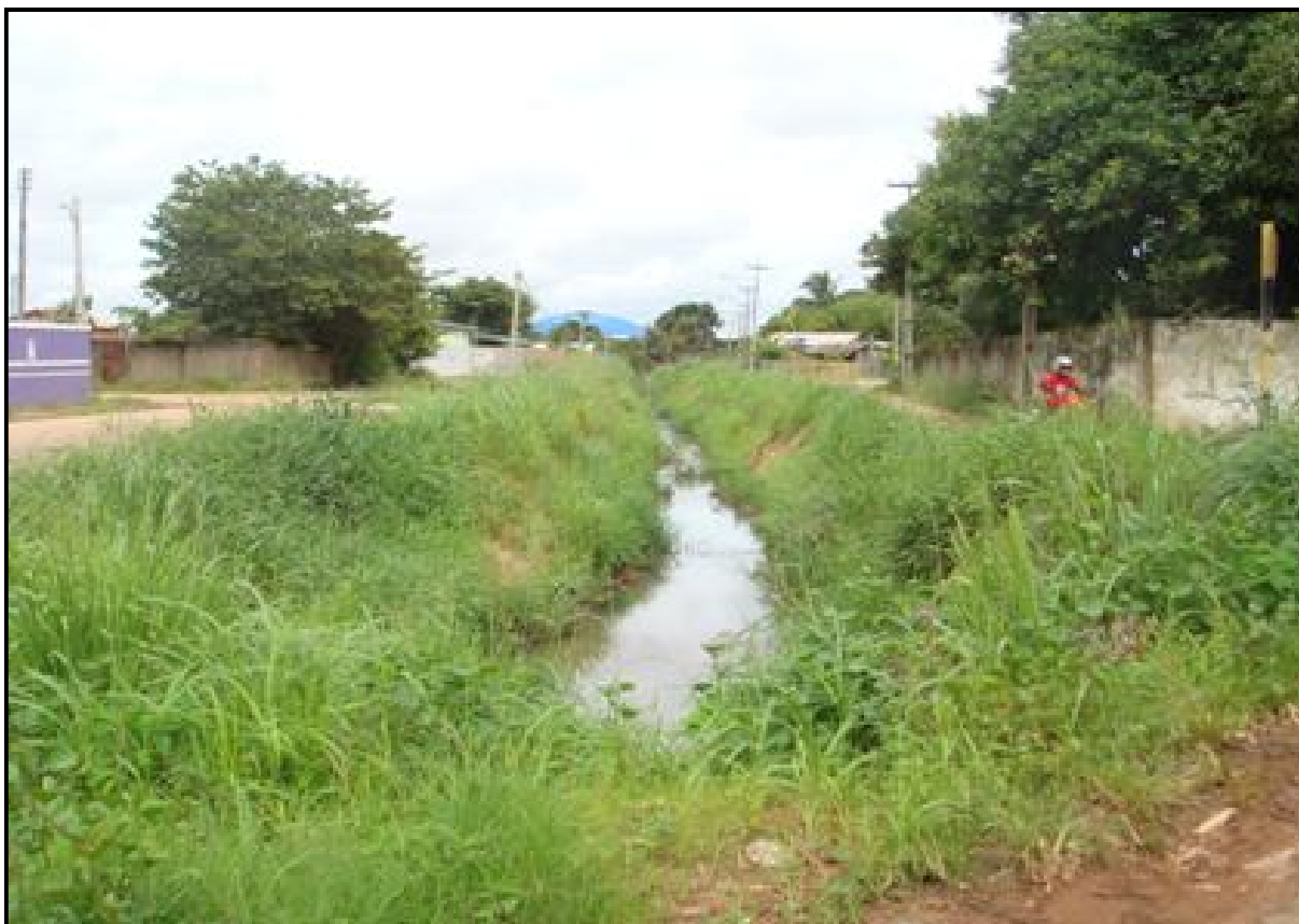
Figura 36 – Canalização na cabeceira do igarapé Uai, localizado em Boa Vista. Moradias em área de alagamento
