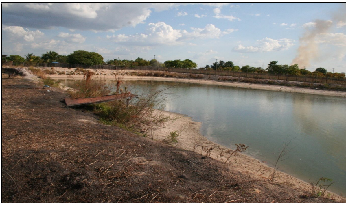
Figura 44 - Vista parcial do açude construído na margem do igarapé Paca localizado em Boa Vista, próximo ao lago.
