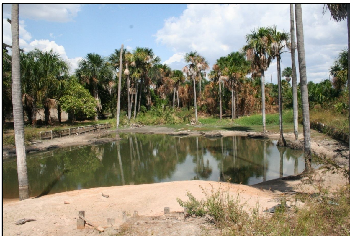
Figura 40 – Vista parcial de açude construído no leito do igarapé Grande na cidade de Boa Vista.
