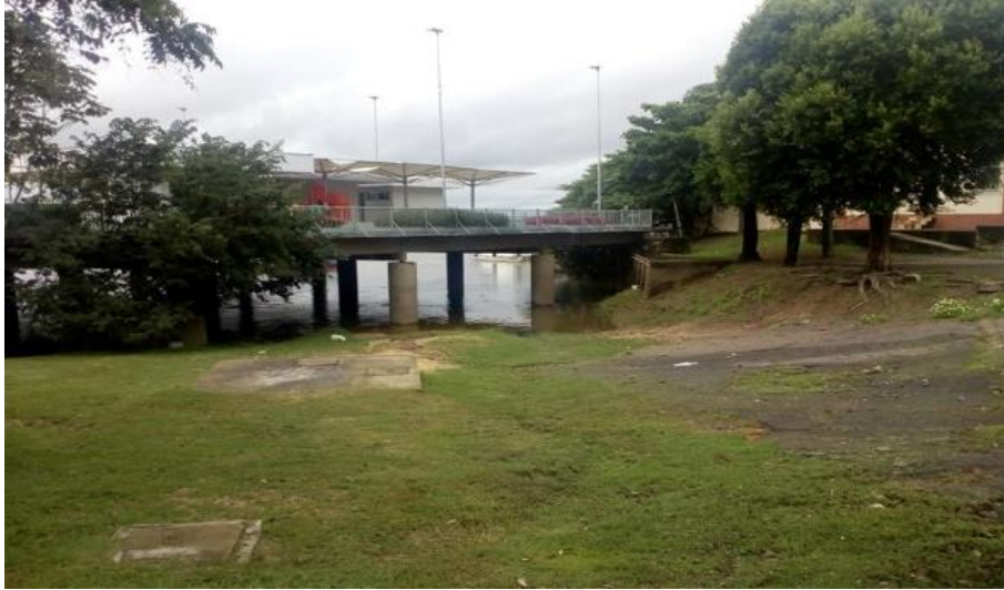
Figura 15 – Acesso ao antigo Porto do Cimento sob a plataforma da Orla Taumanan
