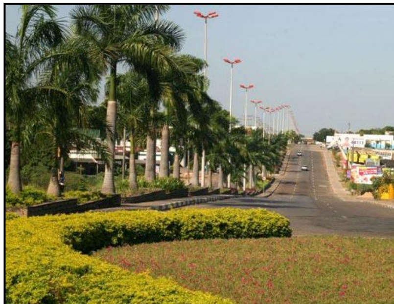
Figura 28 - Avenida Glaycon de Paiva (2004)
