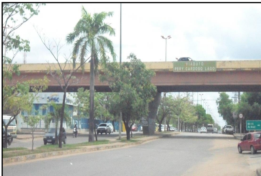
Figura 38 - Viaduto Pery Cardoso Lago (2012)
