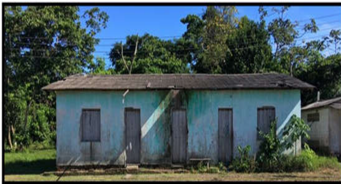
Figura 4 – Prédio antigo da escola municipal de 1º grau Belizio Melo Sobrinho na Comunidade de Terra Preta, Caracaraí/RR.
