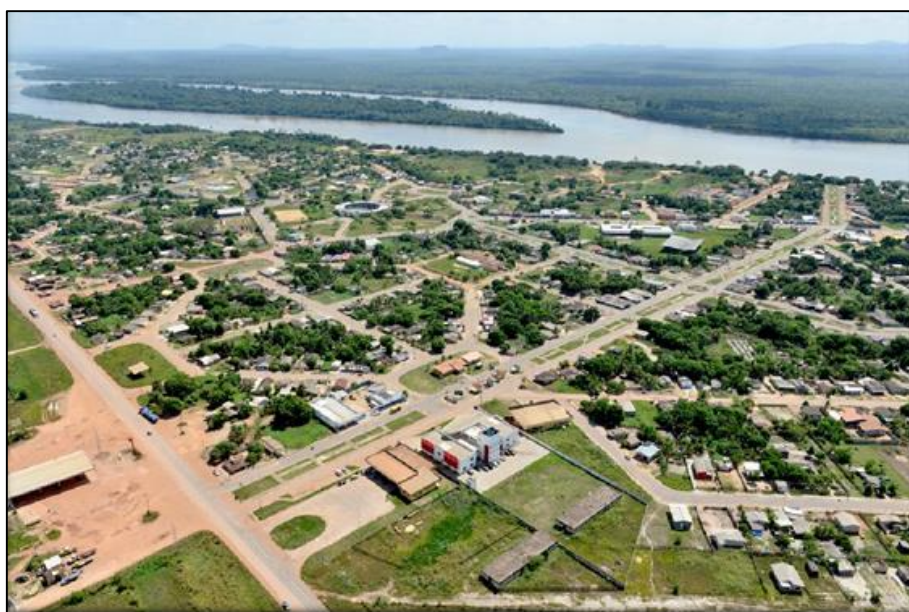
Figura 14 – Vista aérea dos módulos oitavados em 2016.
