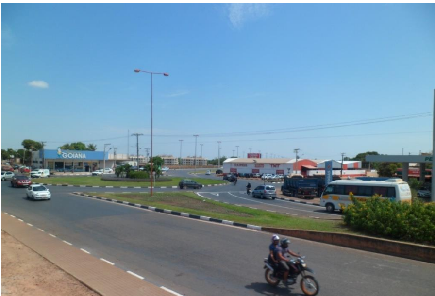
Figura 4: Rotatória na intersecção da Avenida João Alencar com a Rua Joca Farias e Rua Deco Fonteles
