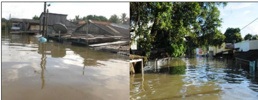
Figura 9 - Situação em que se encontram residências do Beiral, enchente de 2011.
