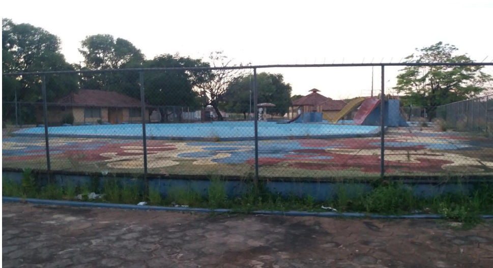
Figura 14: Parque Aquático do Bairro Asa Branca – área da piscina.
