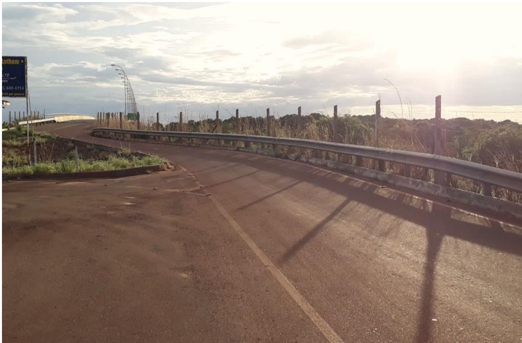
Figura 1 - Ponte sobre o rio Tacutu que liga Lethem a Bonfim: visão a partir do território guianense
