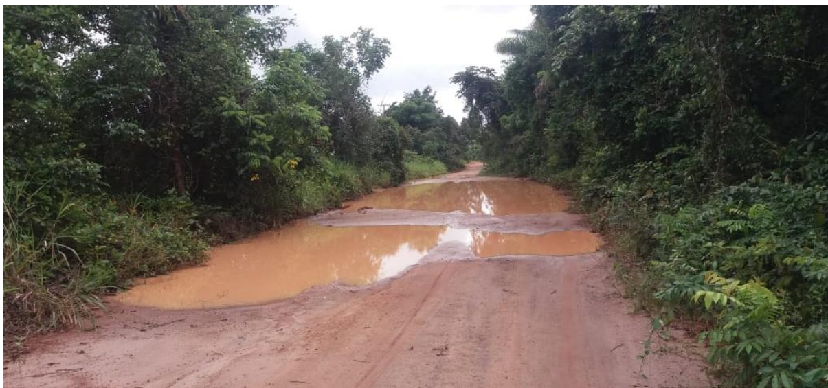
Figura 2 - Tráfego impossibilitado na vicinal 06, município de Mucajaí.
