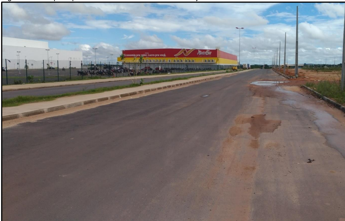
Figura 51 - Via principal de acesso ao futuro condomínio já dotada de infraestrutura.
