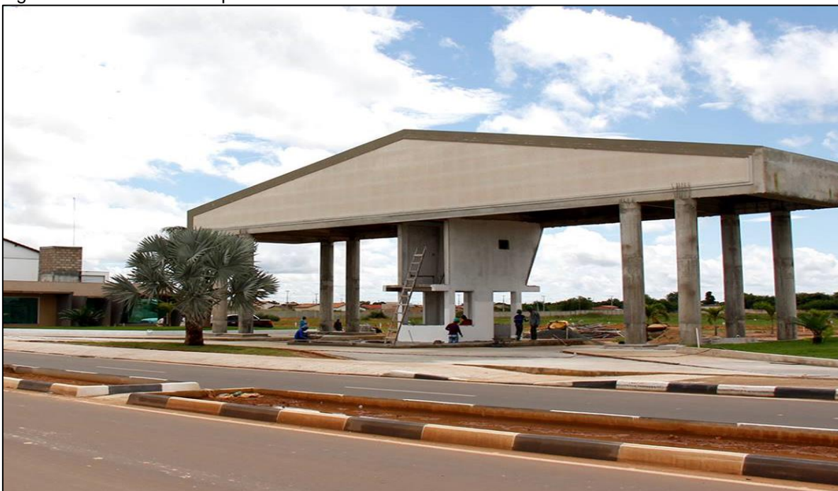
Figura 43 - Entrada do empreendimento com as obras em andamento.
