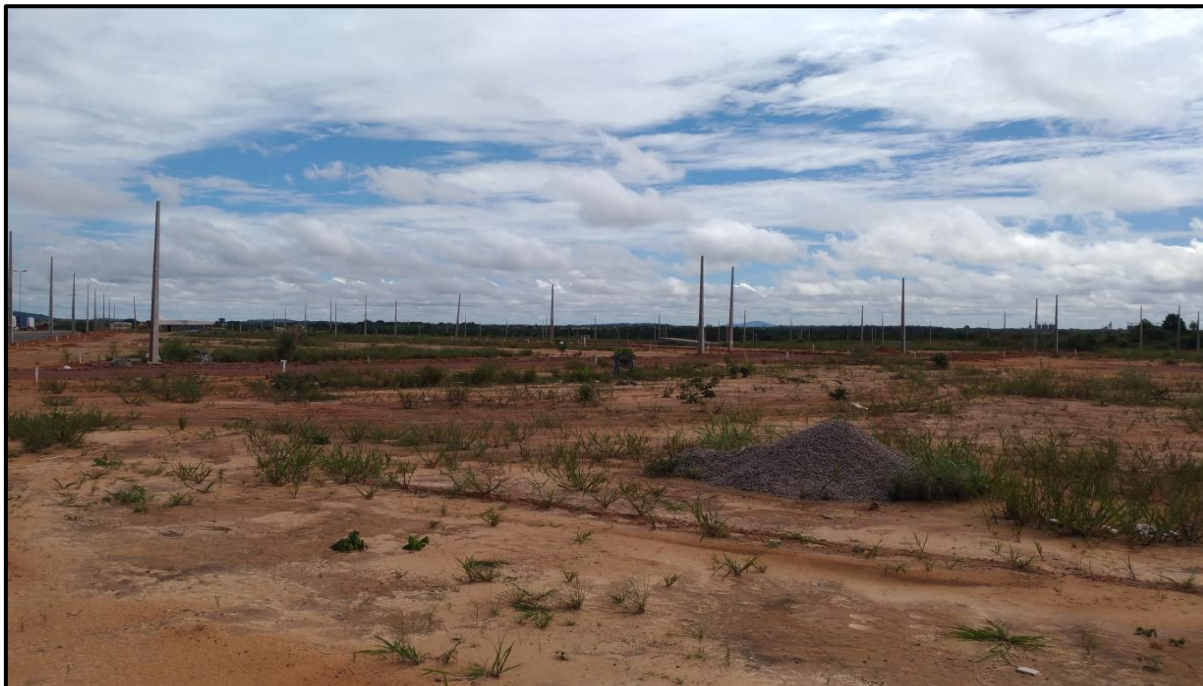
Figura 52 - Visão parcial do futuro condomínio ainda recebendo infraestrutura básica e demarcação dos lotes.
