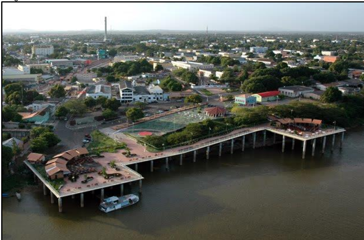
Figura 3 - Orla Taumanan as margens do rio Branco, ocupando o local onde encontrava-se situado o antigo Porto de Cimento.
