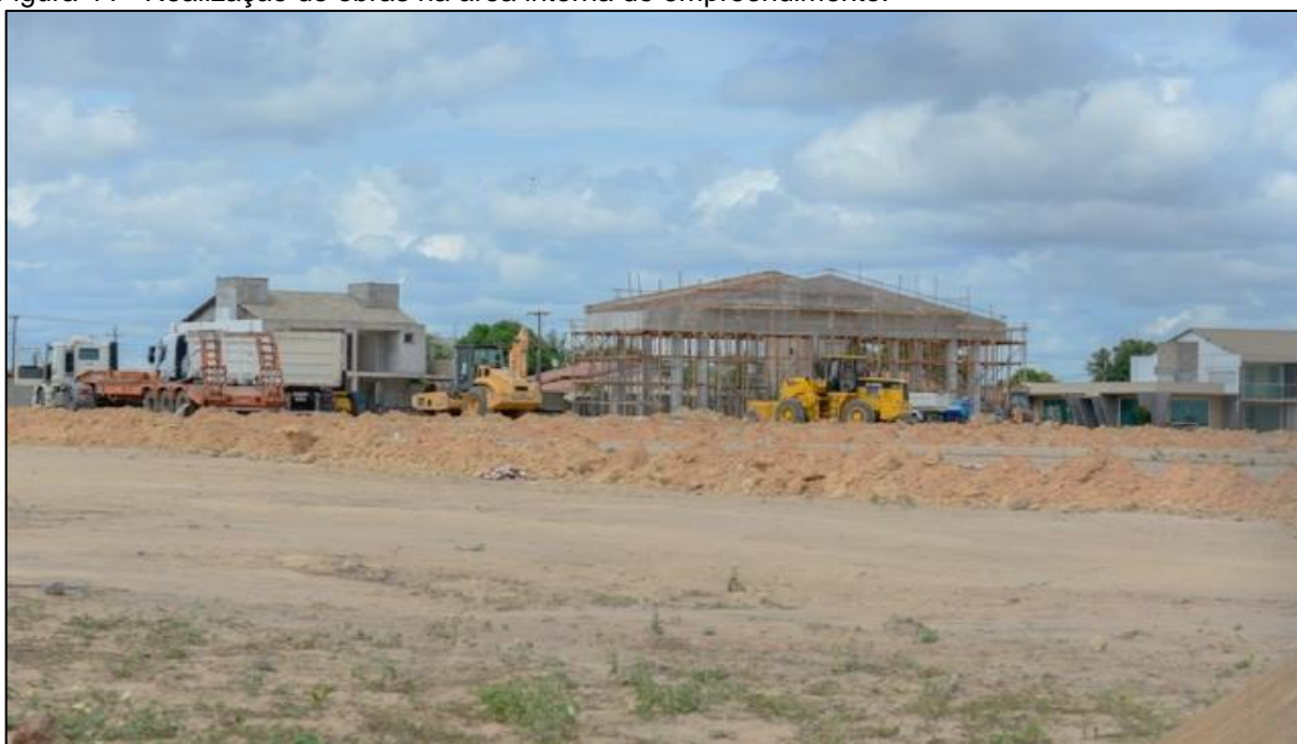
Figura 44 - Realização de obras na área interna do empreendimento.
