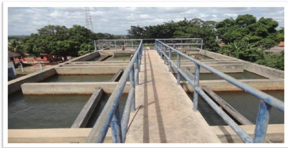
Figura 35 - Estação de Tratamento de Água (ETA/CAERR) em Rorainópolis-RR
