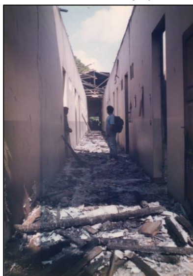
Figura 14 – Área externa da Igreja
