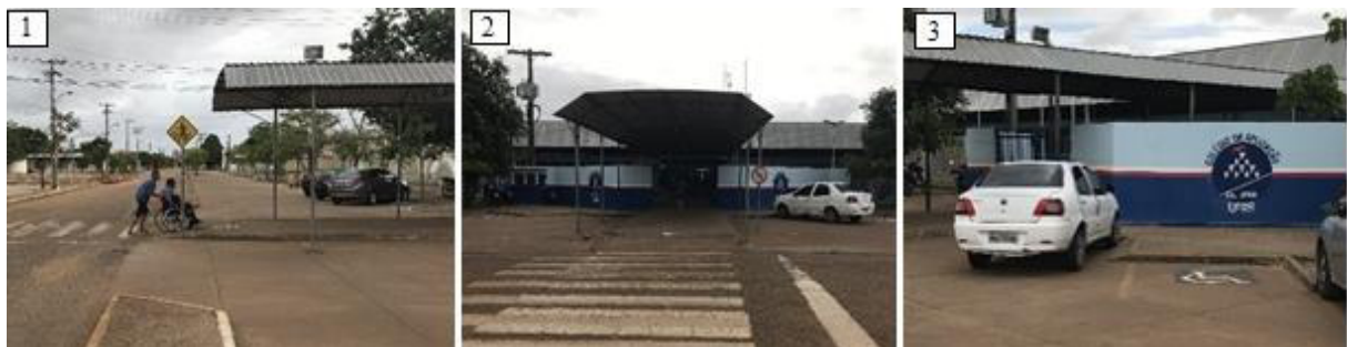
Figura 6 - Acessibilidade na entrada principal do CAp/UFRR: (1) faixa de pedestre com rampas de acesso para a faixa; (2) faixa de pedestre com rampas de acesso para a entrada principal; (3) vagas no estacionamento para pessoas com deficiência.
