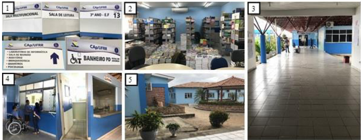
Figura 5 - Espaços sem acessibilidade no CAp/UFRR: (1) placas de identificação; (2) espaço interno da biblioteca; (3) ausência de piso tátil; (4) balcão de recepção elevado; (5) ausência de rampas.
