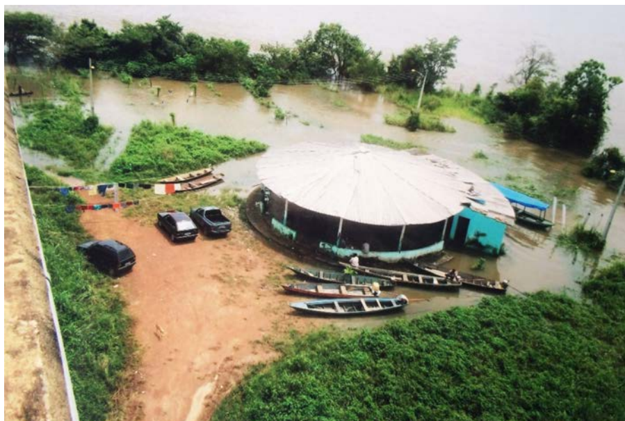
Figura 39 – Projeto compensatório pela construção da ponte
