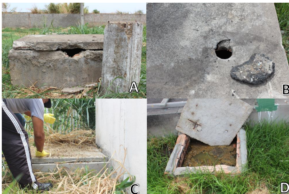
A= Ponto de Coleta 1 (UTI1) B= Ponto de Coleta 2 (UTI2 e 3) C= Ponto de Coleta 3 (Todos os blocos) D= Caixa de passagem de efluentes necessitando de esgotamento.
