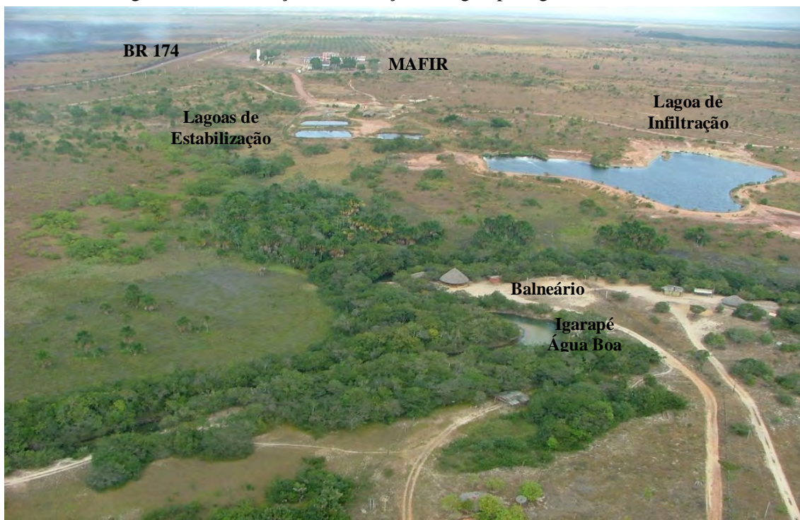
Figura 12 - Foto aérea da localização do Matadouro e Frigorífico Industrial de Roraima - MAFIR, das lagoas de estabilização e infiltração, do igarapé Água Boa e do balneário.
