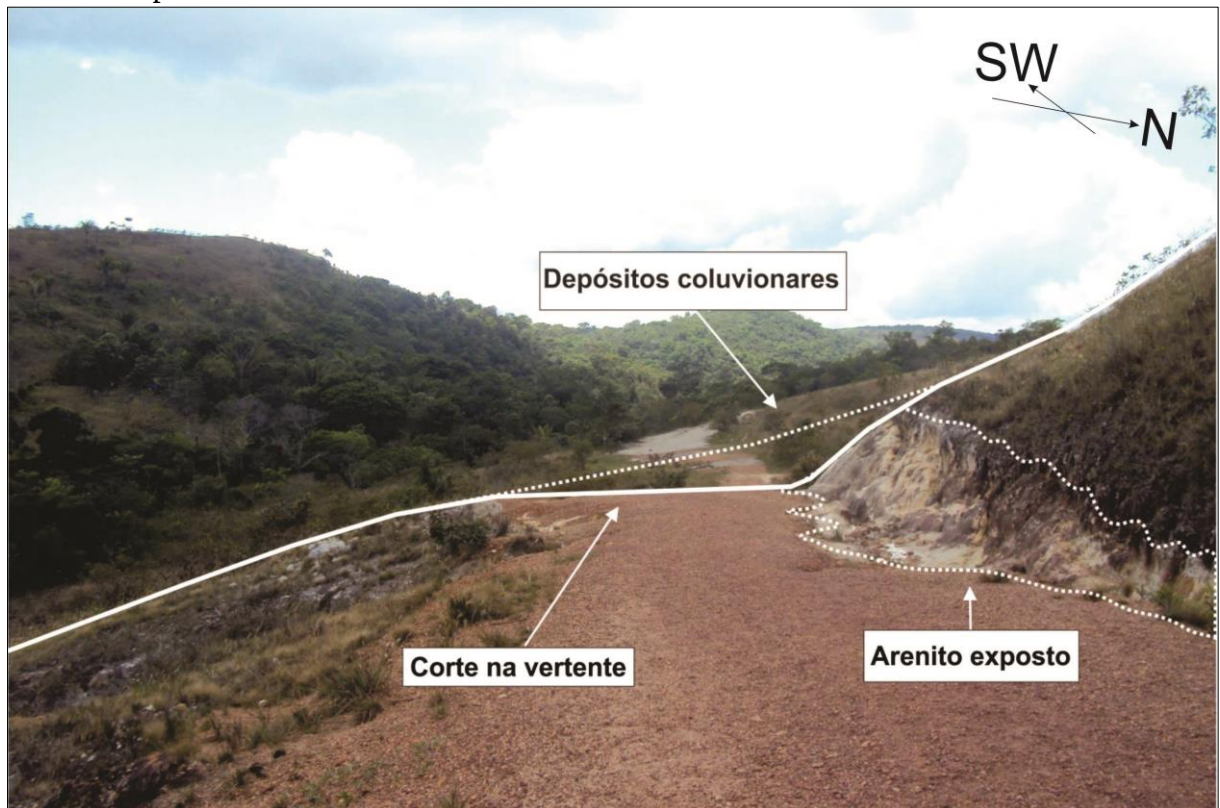
Figura 37 - Vertente do morro Barata com destaque para o corte de estrada, exposição de arenito e depósitos coluvionares.
