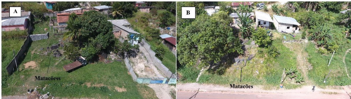
Figura 24 - Construção de moradias no topo e médio do morro do Quiabo.
