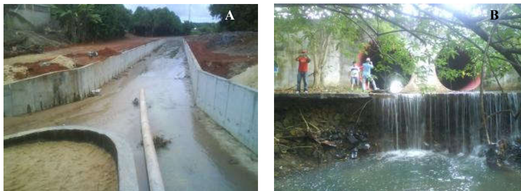
Figura 56 - (A) confluência dos igarapés Tiririca (esquerda) e Jararaca (direita) para formar o igarapé Caxangá, com ênfase para o concretamento e retirada da cobertura vegetal e (B) Trecho do igarapé Mirandinha próximo a desembocadura na Av. Ville Roy.
