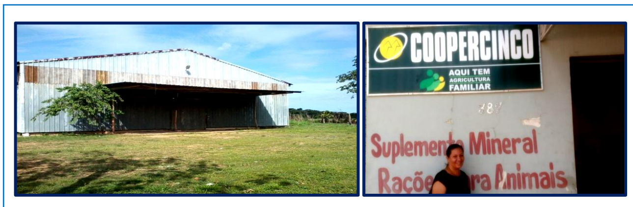
Foto 2 - Registro fotográfico do galpão da Coopercinco no PANA e fachada da sede Administrativa em Boa Vista.
